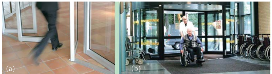
图1. (a) 带紧急打开的平滑门；(b) 自动旋转门方便轮椅的进出。
