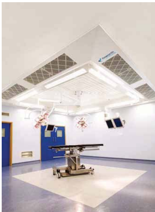
理想的新建或改建工程，使用 Howorth Air Technology 公司的无屏 Exflow 超洁净顶蓬能够降低运行成本。
