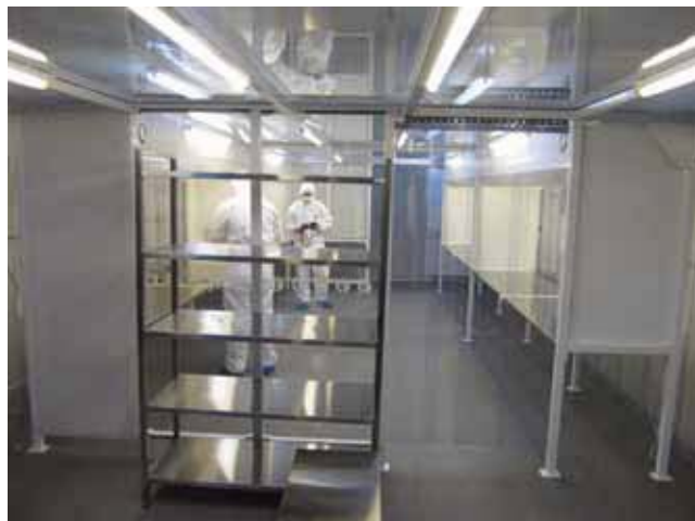
Connect 2 洁净室公司建造这种供电子器件和制药应用的模块化洁净室，这个洁净室是为一家马耳他视觉检查公司建造的。
