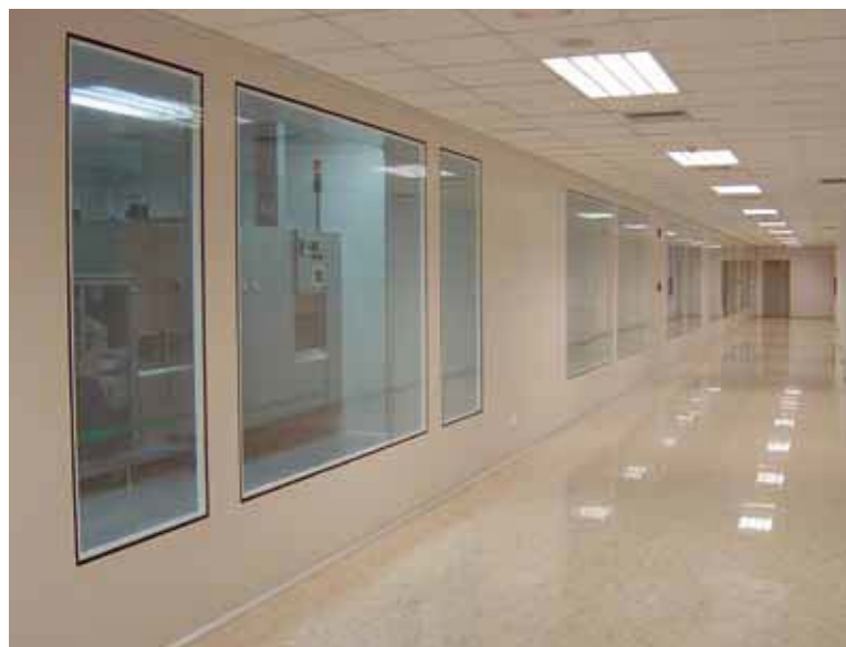
走廊检视窗的例子。
