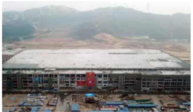
华星光电G11项目主厂房结构封顶
